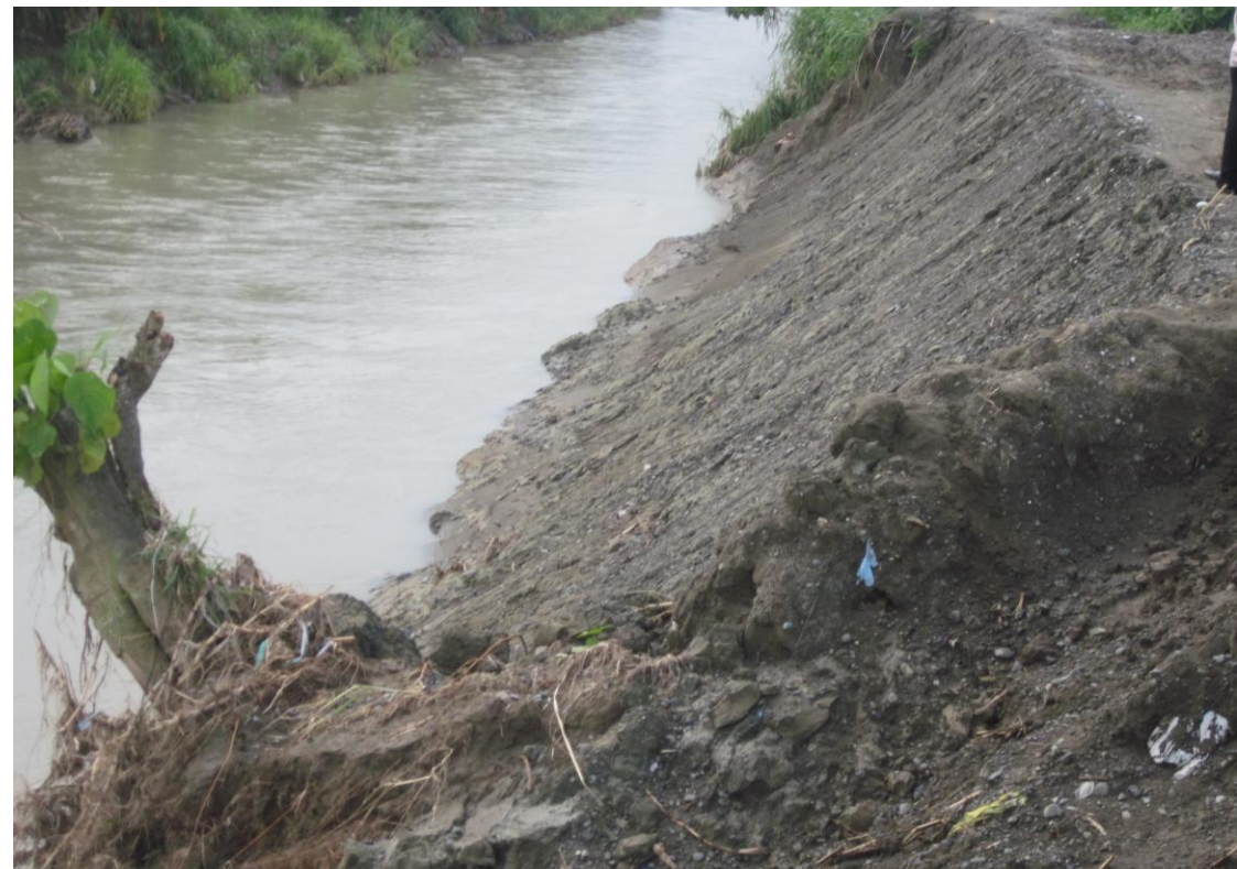
Kini nga bahin sa proteksyon dike sa Tuganay River ang nadamage sa baha ug kinahanglan lig-on ang pagrepair
