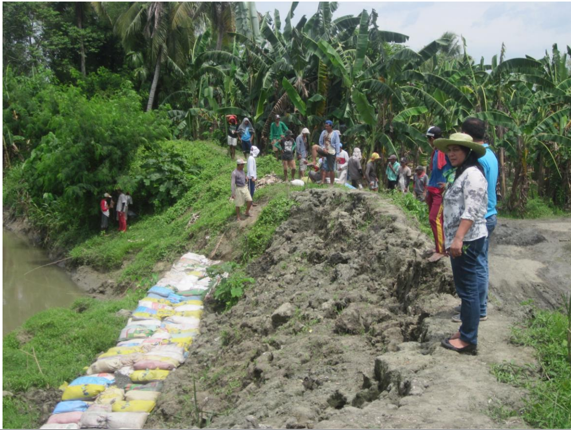
Kini nga bahin sa proteksyon dike sa Tuganay River ang nadamage sa baha ug kinahanglan lig-on ang pagrepair
